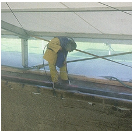
Oberflächenvorbereitung durch Sandstrahlen
