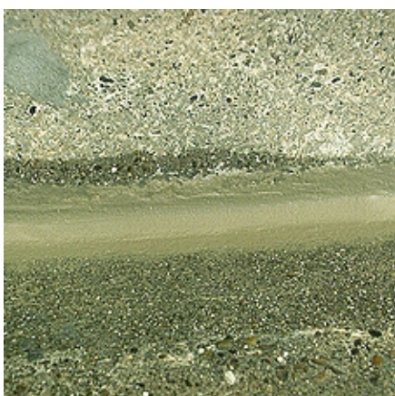
Hohlkehle im Boden-/Wandübergang
