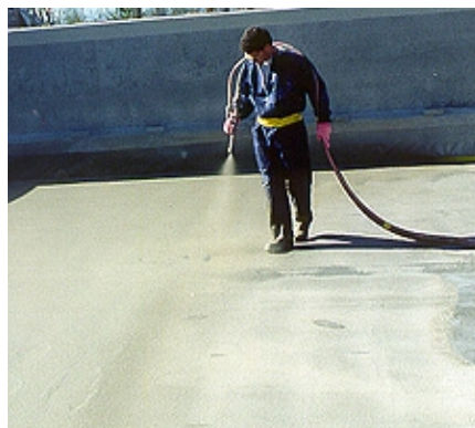
Applikation von VANDEX BB 75 mittels Feinmörtelspritzgerät
