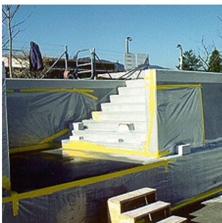
Schützen der behandelten Flächen mit Plastikfolien
