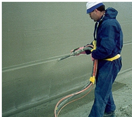
Aufspritzen von VANDEX BB 75, 6 kg/m 2 (3 mm) auf Wandflächen
