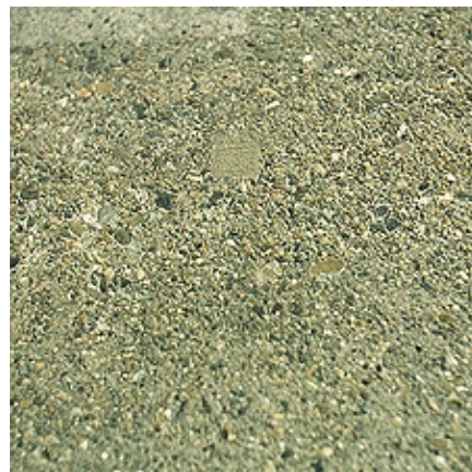
Vorbereiteter Betonuntergrund
