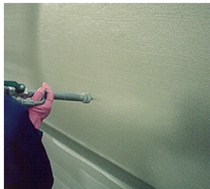
Nahaufnahme der VANDEX BB 75 Spritzapplikation
