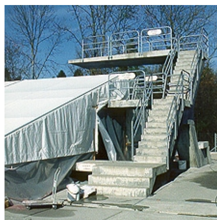
Vorübergehender Witterungsschutz während der VANDEX Applikation
