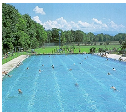
Im VANDEX Sanierungssystem saniertes Schwimmbaden
