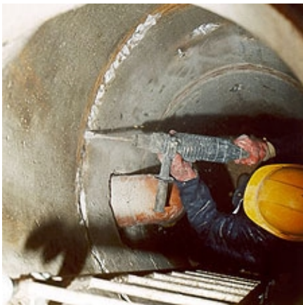
Ausspitzen der schadhafte Risse und Fugen
