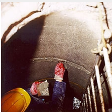
Reprofilieren der Fugen mit VANDEX UNIMÖRTEL
