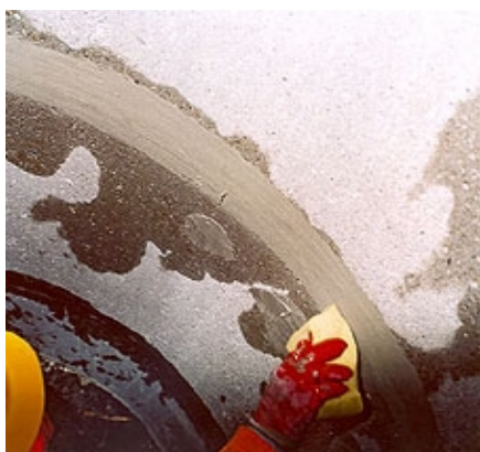
Abglätten von VANDEX BB 75 mit dem Schwamm
