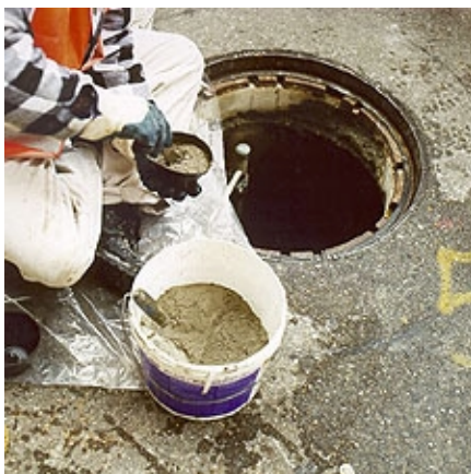
Anmischen von VANDEX WASSER-STOPPER
