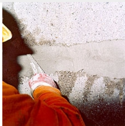
Reprofilieren der Fugen mit VANDEX UNIMÖRTEL
