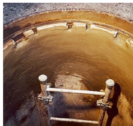
Oberer Schachtbereich beschichtet mit VANDEX BB 75
