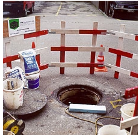
Lokale Baustellensicherung der 40 zu sanierenden Kontrollschächte
