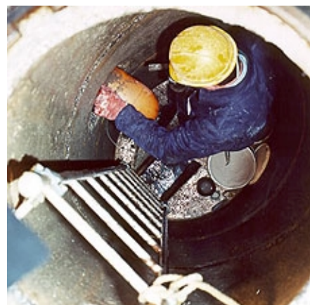
Stopfen der schadhafte Rohrführungen
