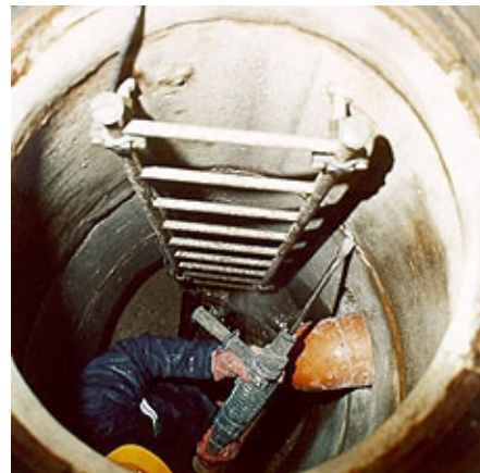
Ausspitzen der schadhafte Risse und Fugen
