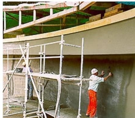
Auch während der Beschichtungsarbeiten sind diese gegen Regen, Sonne und Wind mit Abdeckungen zu schützen
