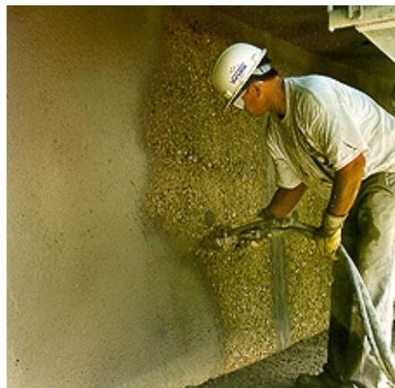
Spritzapplikation von VANDEX UNI-MÖRTEL 1 Z, 5 - 7 kg/m<sup>2</sup> (3mm)
