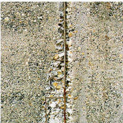
Freigelegter Bewehrungsstahl, der mit VANDEX CRS KORROSIONSSCHUTZ AC beschichtet wird
