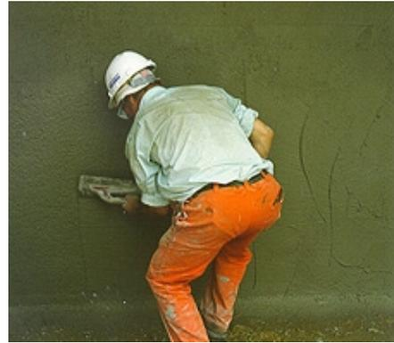
Abziehen der ersten Schicht VANDEX UNIMÖRTEL 1 Z mit der Stahltraufel
