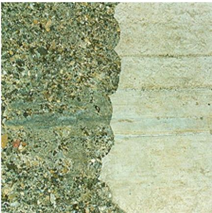
Nach der Reinigung ist der Zementleim entfernt, es bleiben nur die Spuren der rotierenden Düse sichtbar
