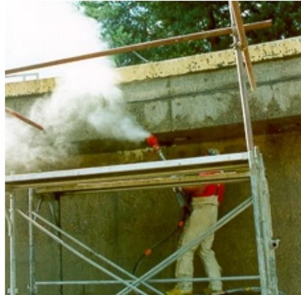
Alle Betonoberflächen wurden mit Höchstdruckwasserstrahl-Technik (2'500 bar) vorbereitet
