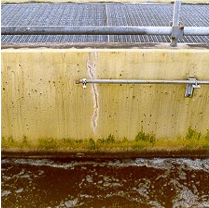
Bestehende Situation: die Epoxid-Beschichtung im oberen Beckenbereich ist stark beschädigt
