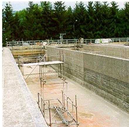
Das Vorklärbecken nach der Untergrundvorbereitung mit der Höchstdruckwasserstrahl-Technik
